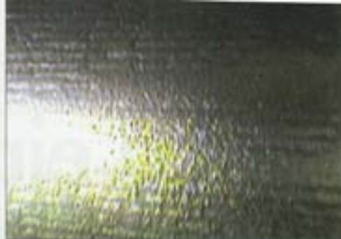
Abb. 2: Gute Oberflächenbeschaffenheit: Innenansicht Zapfhahnauslauf mittels Videoendoskopie
